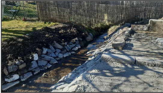
Abb. 3: Schönfelder Bach, aufgeweitetes und naturnah gesichertes Gerinne, 23.03.2022
