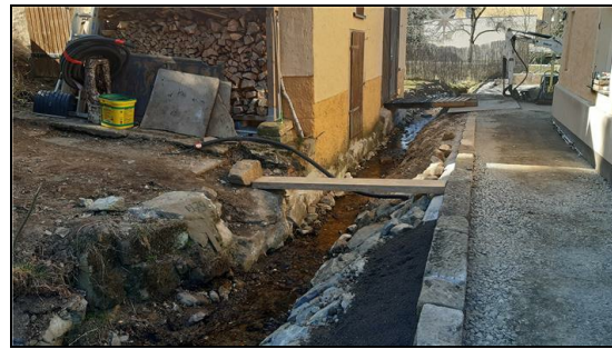
Abb. 4: Schönfelder Bach, aufgeweitetes und naturnah gesichertes Gerinne, 23.03.2022
