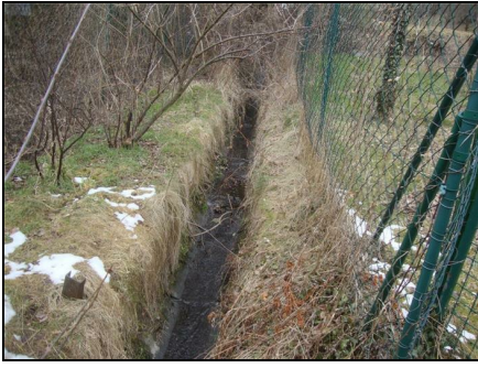
Abb. 2: vor Maßnahmeumsetzung: Sohlbefestigung mit Betonhalbschale, 05.03.2020
