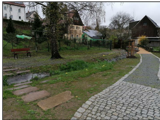
Abb. 5: nach Fertigstellung: Klotzcher Dorfbach und gewässerbegleitende Freifläche, 17.04.2023
