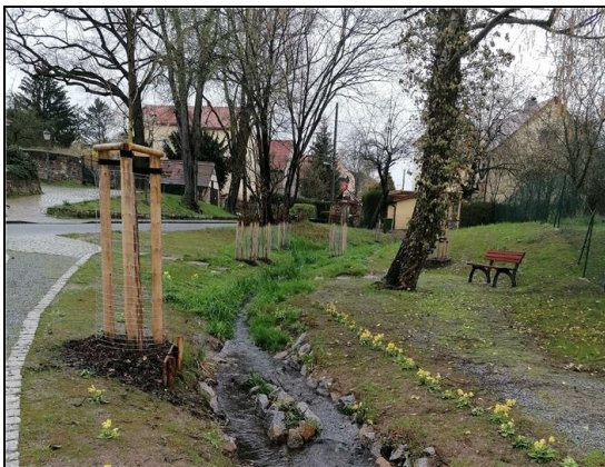
Abb. 4: nach Fertigstellung: offen gelegter Bachabschnitt mit naturnaher Ufersicherung, 17.04.2023
