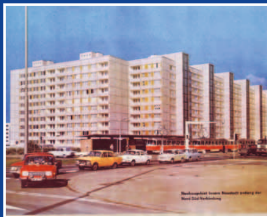
Neubaugelände an der heutigen Albertstraße (Sarasanstraße) in den 70er Jahren.
