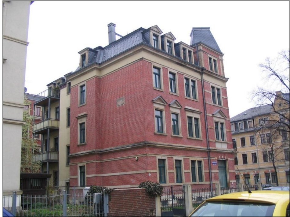
21 – Frankenbergstraße 16, Sanierung gefördert, 2011 - Endwertqualität
