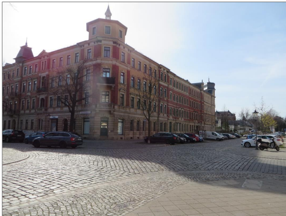
71 – Kreuzung Bonhoefferplatz / Poststraße / Leumerstraße, 2020 - Endwertqualität
