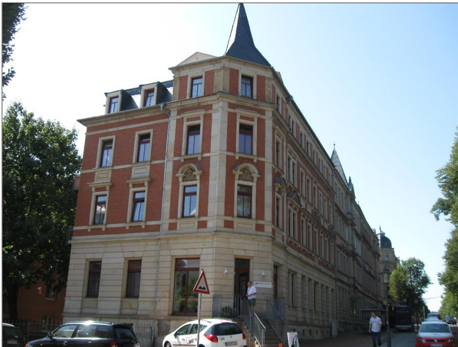
20 – Hainsberger Straße 2, Sanierung gefördert, 2011 - Endwertqualität
