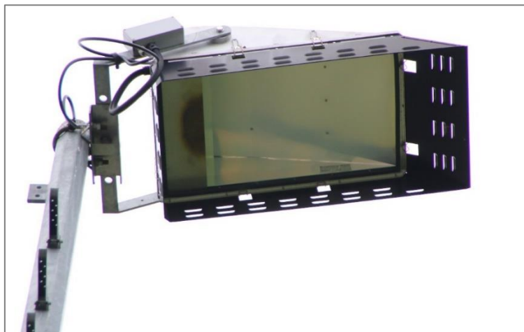
Abbildung 5. Flutlicht mit montierter Blende zur Reduzierung des Streulichts.
