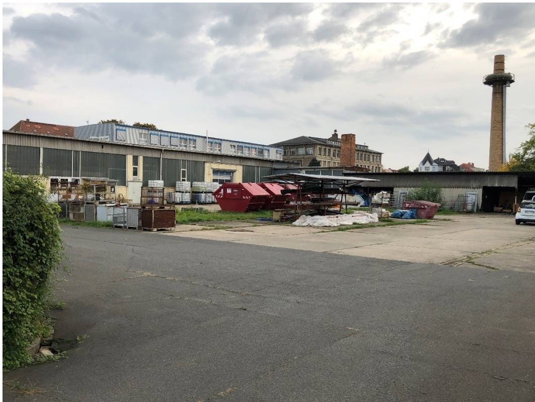
Abb. 14: Straßenabgewandte, überwiegend versiegelte Betriebsflächen; Schornstein
