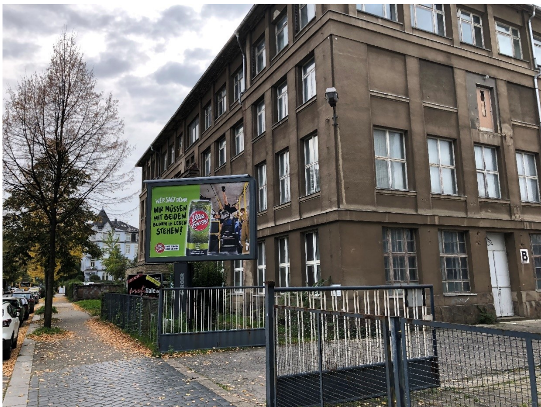
Abb. 16: Mehrgeschossiges Altgebäude an der Schlüterstraße; leerstehend
