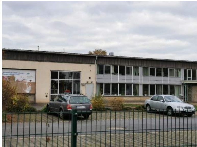
Abb. 5: Wellblechverkleidung im oberen Fassadenbereich; mögliches Habitat für Fledermäuse
