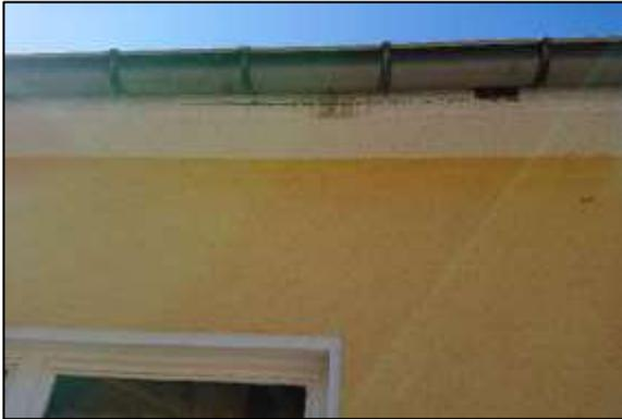
Foto 7: Nordfassade der Cafeteria mit Rissen im Mauerwerk
