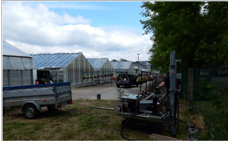
Abb. 1: Blick in Richtung Nordosten auf den südlichen Teil des Baugeländes
