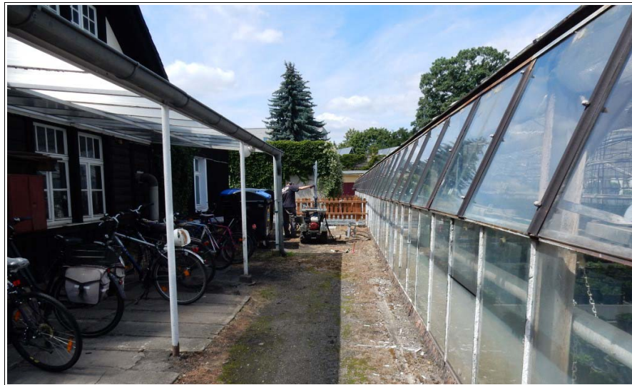
Abb. 2: Blick in Richtung Nordwesten auf den nördlichen Teil des Baugeländes
