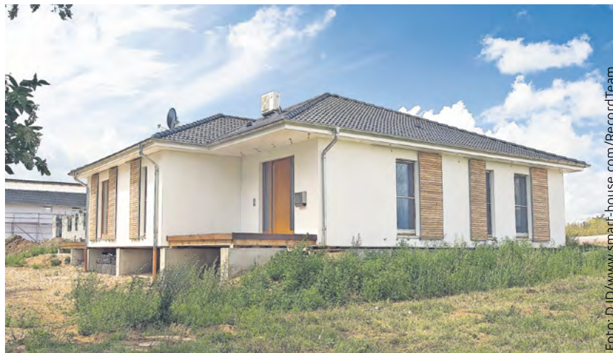
Holzmodulhäuser werden auf Streifen- oder Punktfundamenten errichtet. Eine vollflächige Bodenversiegelung wird dadurch vermieden.
