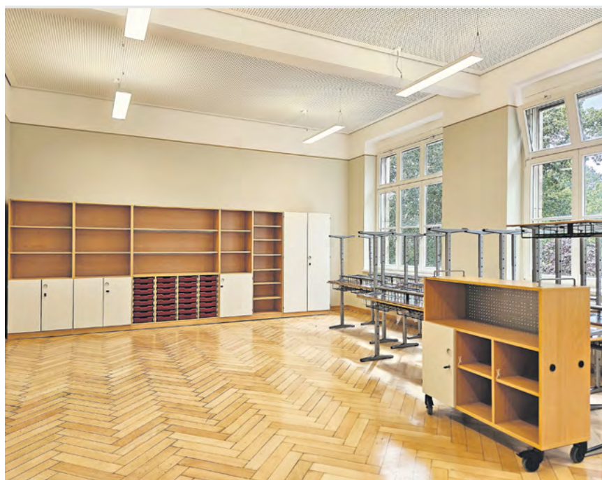
68. Grundschule. Blick in einen sanierten Klassenraum mit aufgearbeitetem Parkett, neuem Anstrich und Beleuchtung sowie Lärmschutzdecke. Fotos (3): Josefine Bachofner
